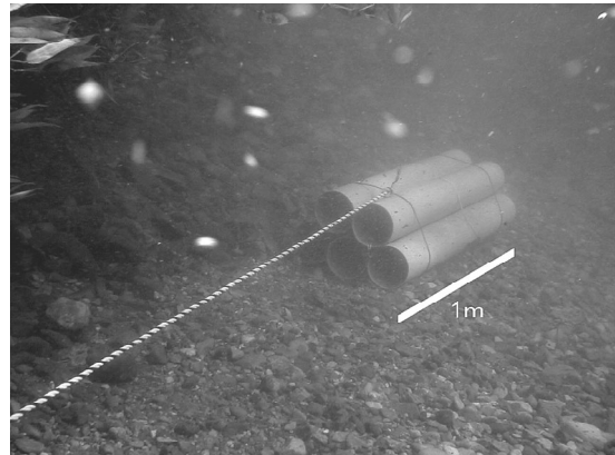
図5.4-14 塩ビ管設置図（全体）
