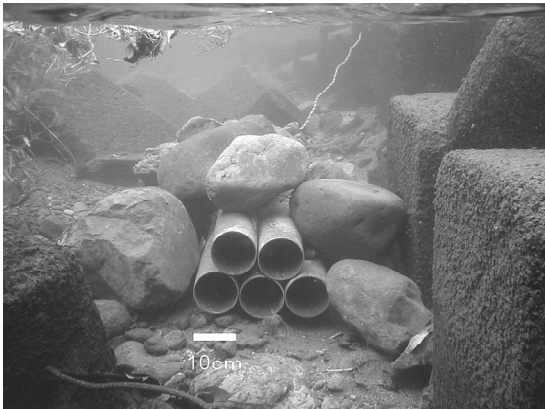
図5.4-13 塩ビ管設置図（開口部）
