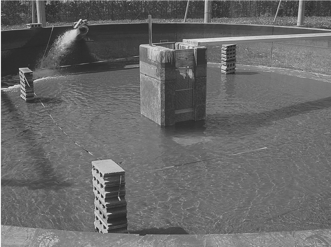
図5.2-15 防鳥テープ設置
